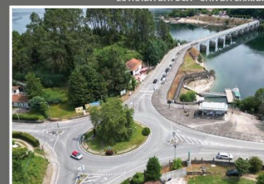
REQUALIFICAÇÃO DE PAREDES - RIO CALDO
